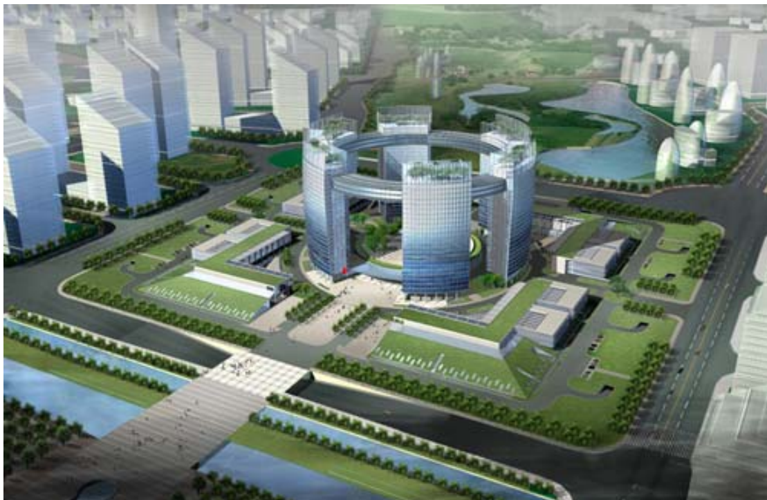
杭州市市民中心钱江新城冰蓄冷空调项目
